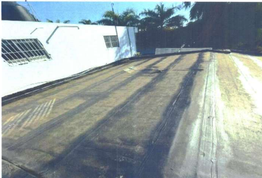
Foto 1 y 2: Colocación de lona asfáltica.
