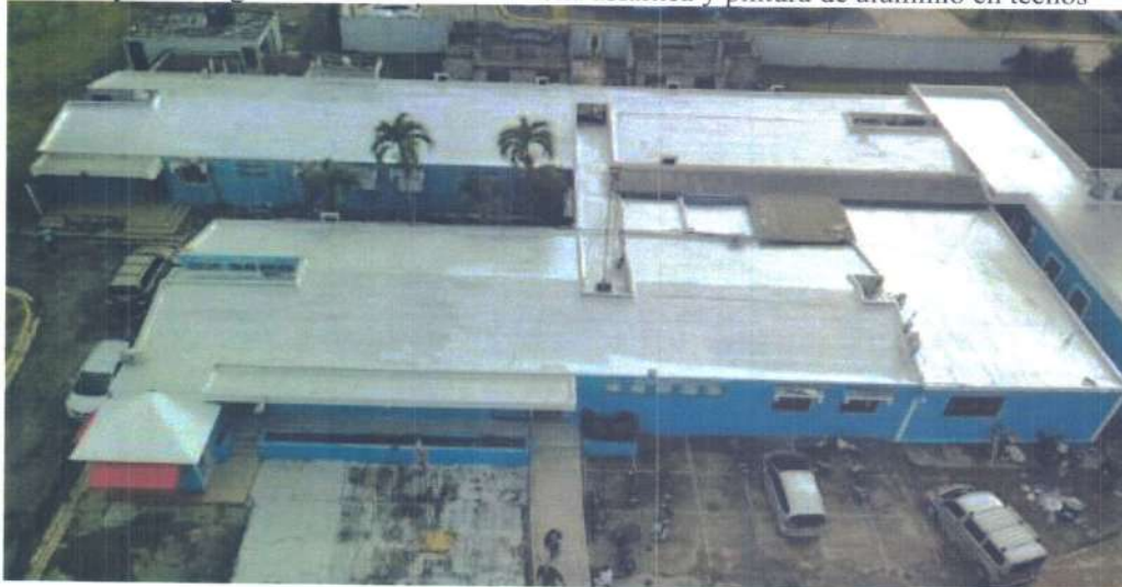
Foto 10 y 11: imágenes de colocación de Lona asfáltica y pintura de aluminio en techos
