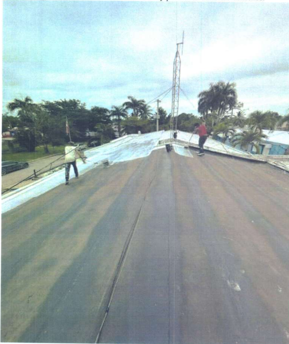
Foto 7: imagen de colocación de Lona asfáltica y pintura de aluminio en techos.
