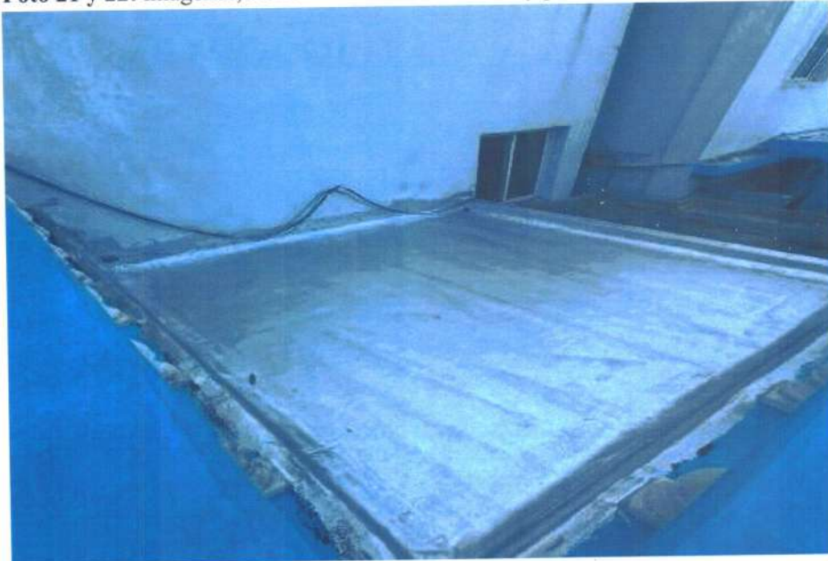
Foto 21 y 22: imágenes, colocación de lona asfáltica y pintura de aluminio en techos
