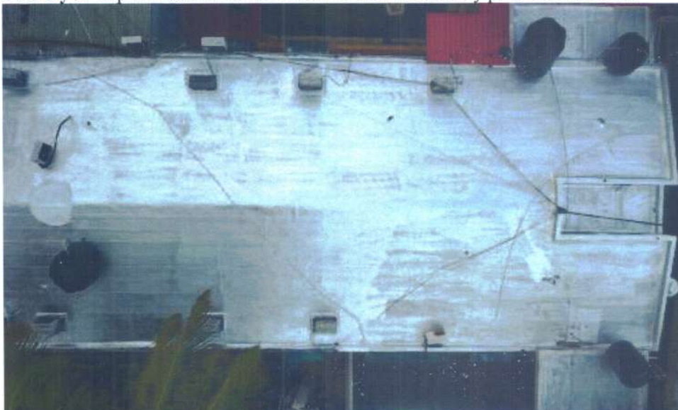
Foto 8 y 9: Impermeabilización de techos con lona asfáltica y pintura de aluminio
