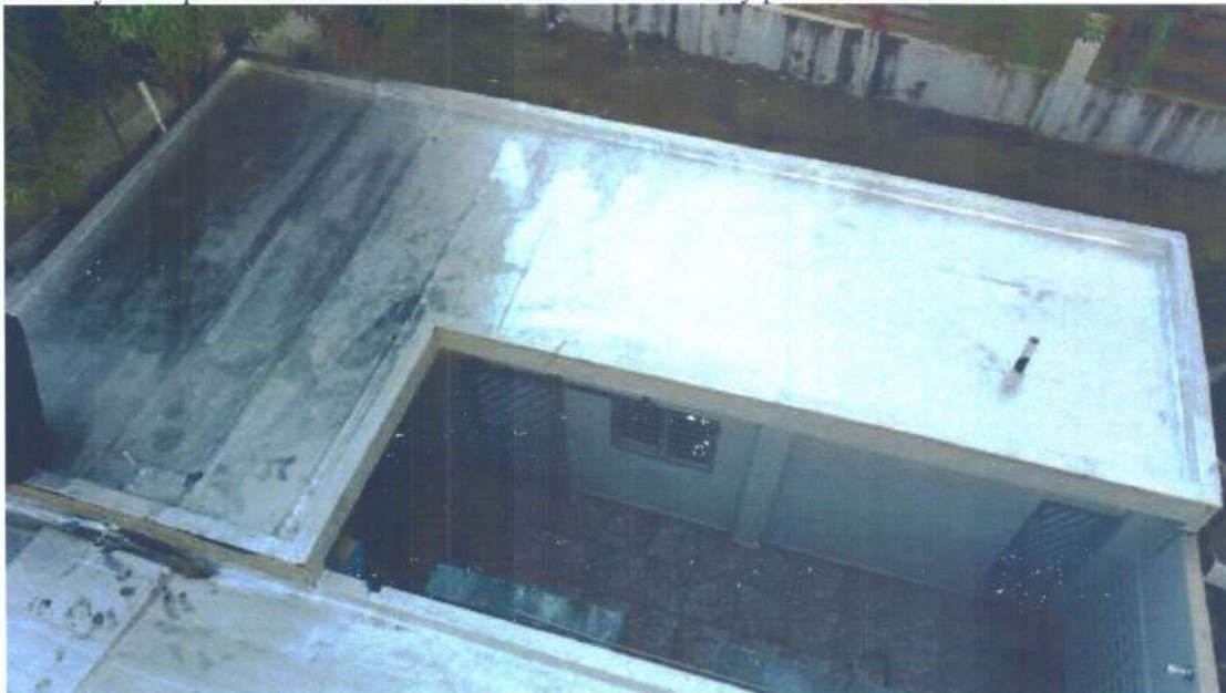
Foto 8 y 9: Impermeabilización de techos con lona asfáltica y pintura de aluminio.
