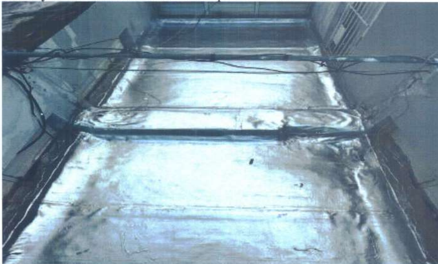
Foto 6 y 7: Pintura de aluminio sobre capa de Lona asfáltica.
