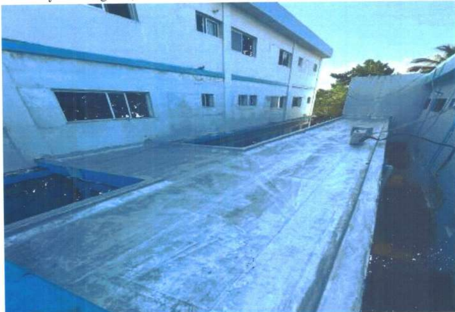
Foto 19 y 20: imágenes, colocación de lona asfáltica y pintura de aluminio en techos
