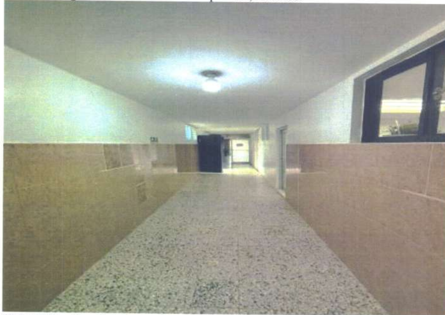
Foto 4: imagen de remozamiento de pintura, Pasillos.
