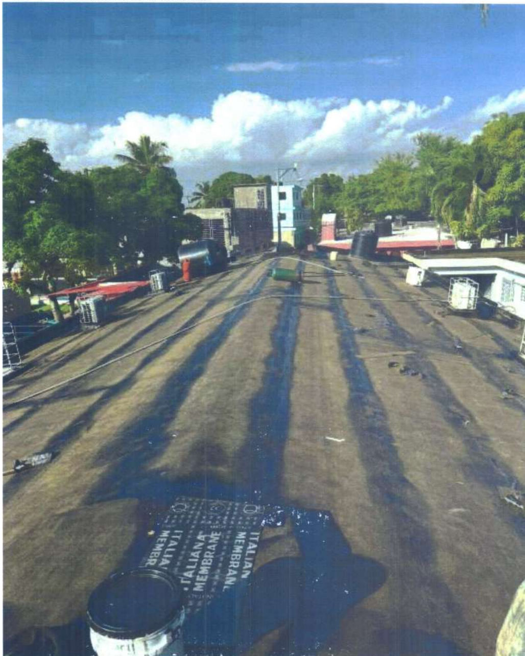
Foto 4: Colocación de lona asfáltica.
