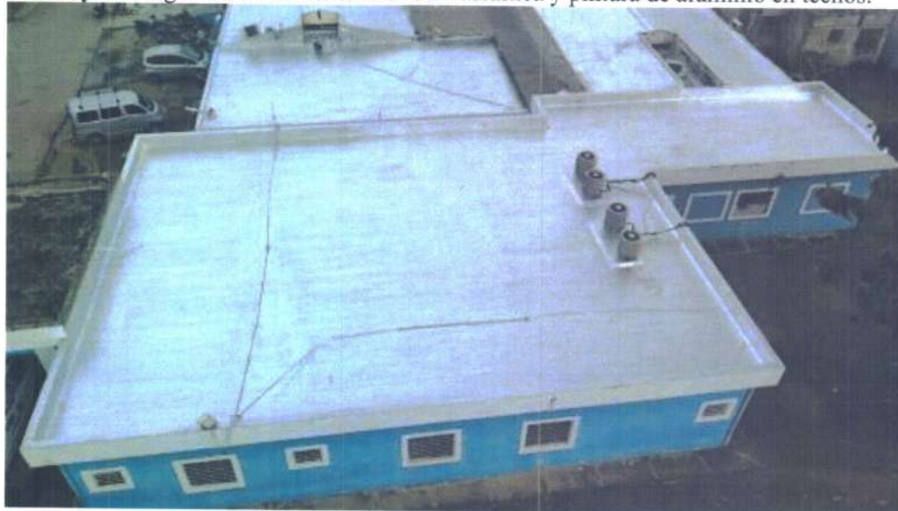
Foto 8 y 9: imágenes de colocación de Lona asfáltica y pintura de aluminio en techos.
